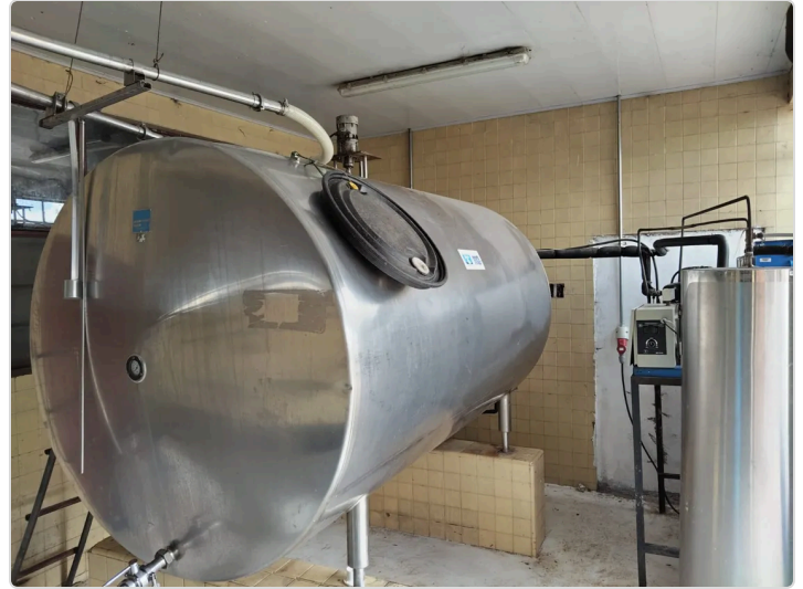
Figura 4. tanque de almacenamiento y enfriamiento de leche
