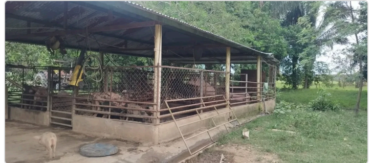
Figura 1. Instalación Granja Ochoa
