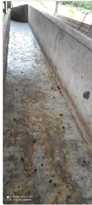
Figura 4. Instalaciones sistema de producción en el corral
