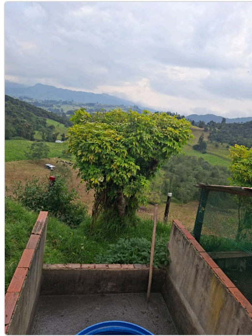
Figura 4. Desagüe de la zona 1 de la producción
