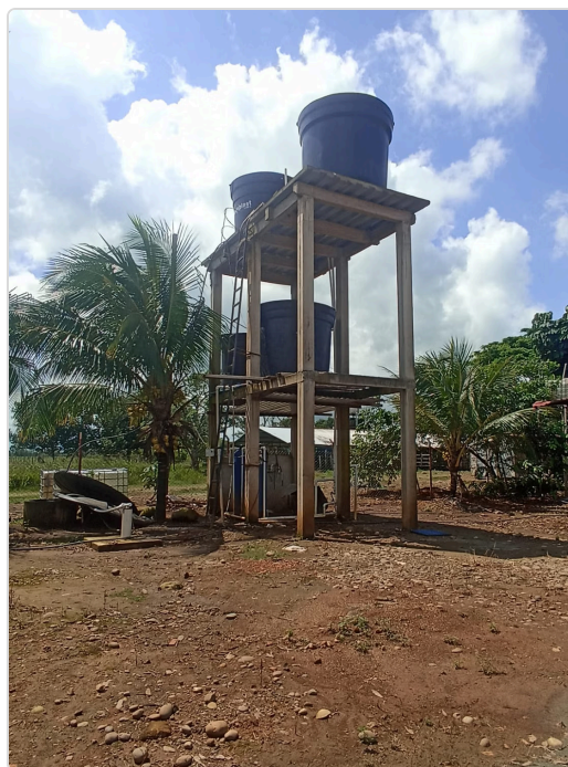
Figura 14. pozo profundo recurso hídrico, filtro – equipo de potabilizar el agua, tanques de almacenamiento de agua potable.
