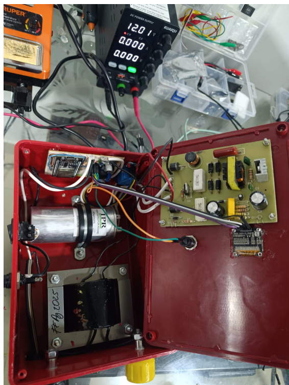
(a) Disposición interna y gestión de cableado
