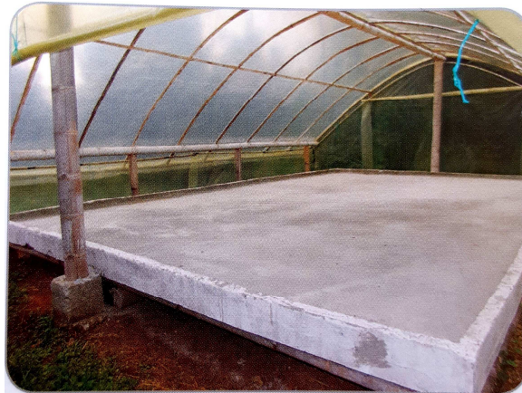
Figura 2. Secador solar parabólico con piso en concreto
