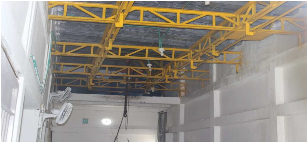
INSTALACIONES MATADERO PUERTO CARREÑO
