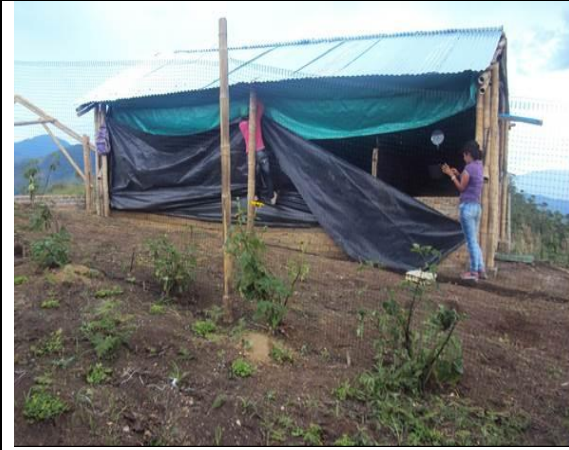
Figura2: Adecuación de Galpón Fuente: la autora
