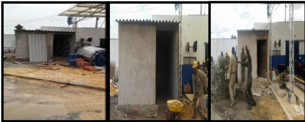
Imagen 6. Nivelación Piso, Techado y Puesta de Nueva Infraestructura.
