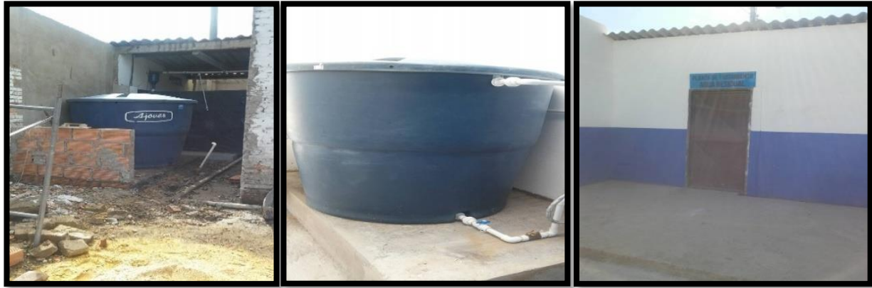
Imagen 21. Adecuación del tanque trasladado para la optimización de la PTAR Fuente de autor Hernández. D. (2016).
