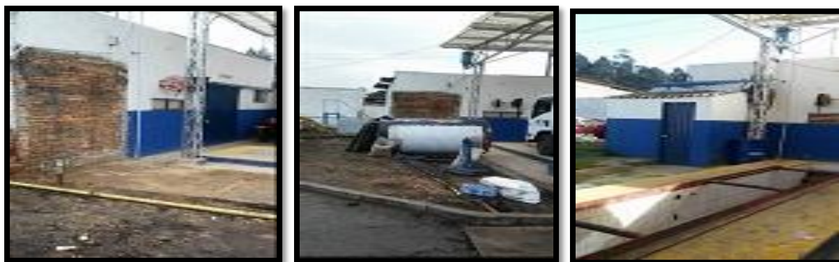
Imagen 20. Antigua área del tanque de almacenamiento de agua tratada, desmonte del tanque y demolición de infraestructura. Fuente de autor Hernández. D. (2016)
