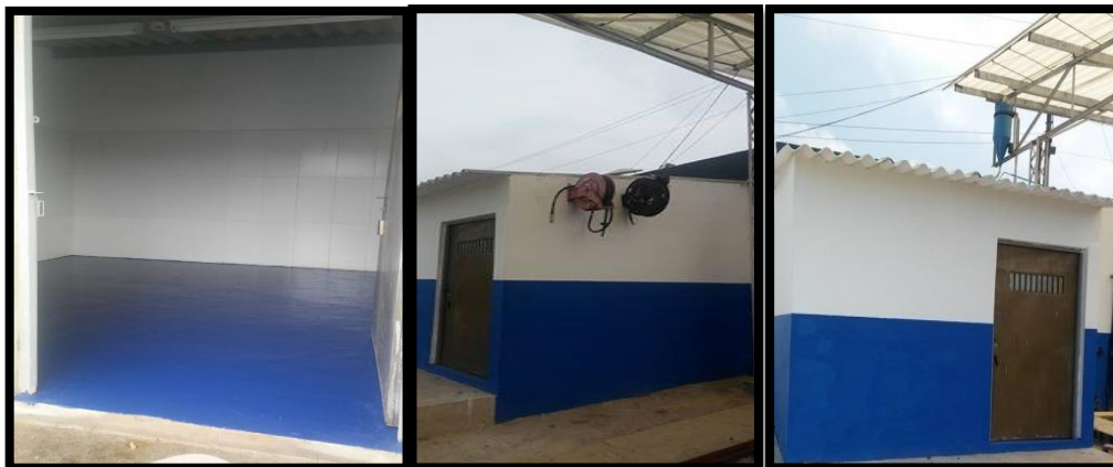
Imagen 7. Fase final de obra infraestructura para depositar los RESPEL Fuente de Autor Hernández. D. (2016)
