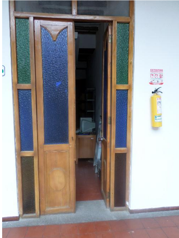
Figura 12. Puerta acceso Servidor de Control de Asistencia Administrativos
