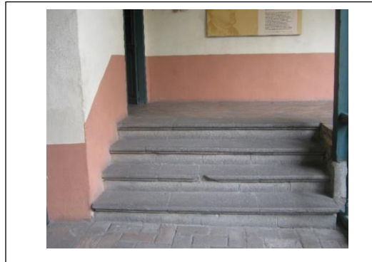
Figura 21: Ingreso a la cocina.
