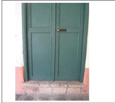
Figura 18: Ingreso sala1. Patio 1. Costado izquierdo.
