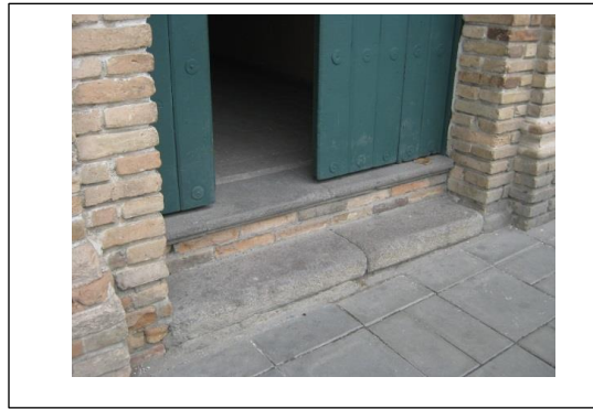
Figura 8: Detalle puerta principal calle 5.
