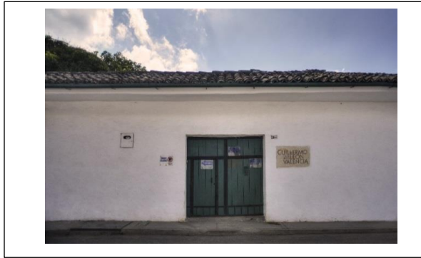
Figura 10: Fachada lateral de la Casa Museo Guillermo León Valencia. Carrera 10 Popayán.
