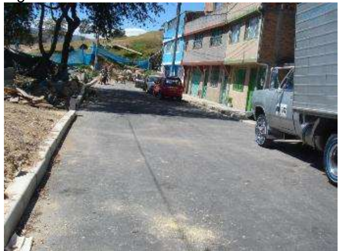
Figura 9 Tramo vial intervenido
