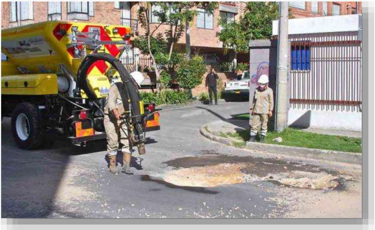
Figura 5. Ejemplo proyecto Tipo C: Mantenimiento puntual de vía, Bogotá.
