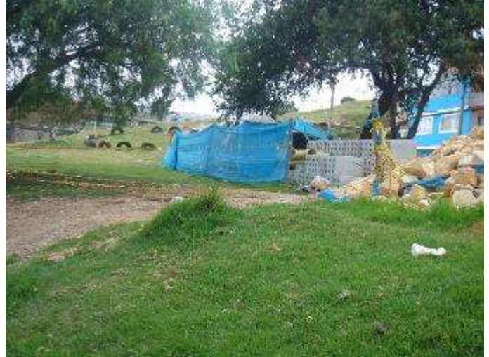
Figura 7 Acopio de material de obra
