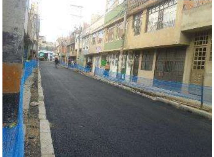
Figura 15 Tramo vial intervenido
