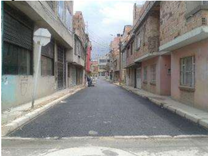
Figura 13 Tramo vial intervenido
