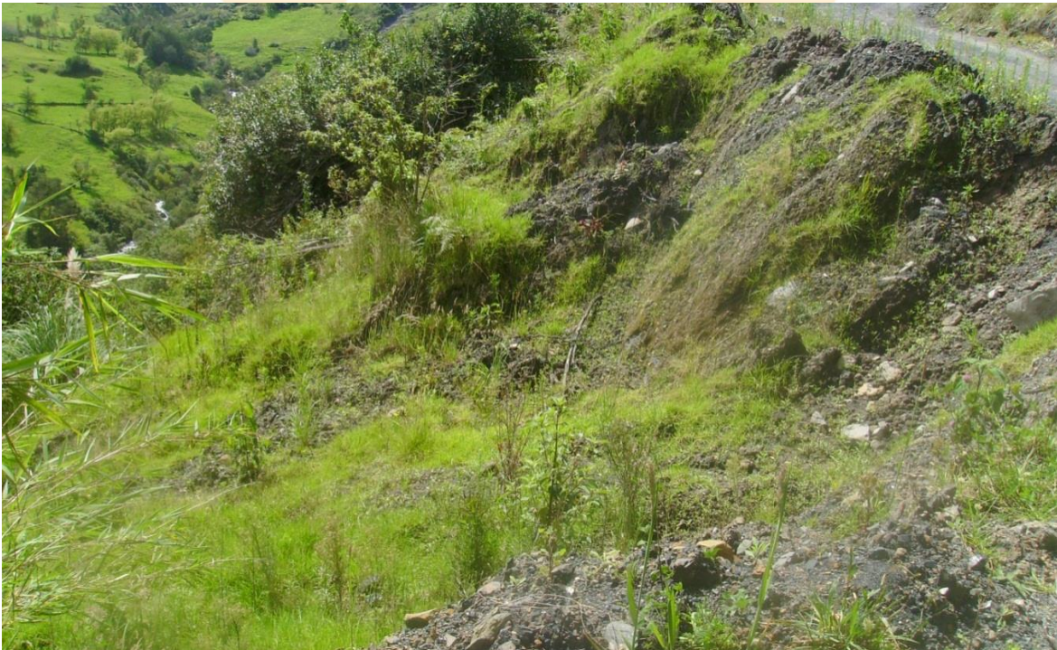
Foto 3. Detalle de la contaminación de las aguas quebrada de Valero vereda de Santa Ana.
