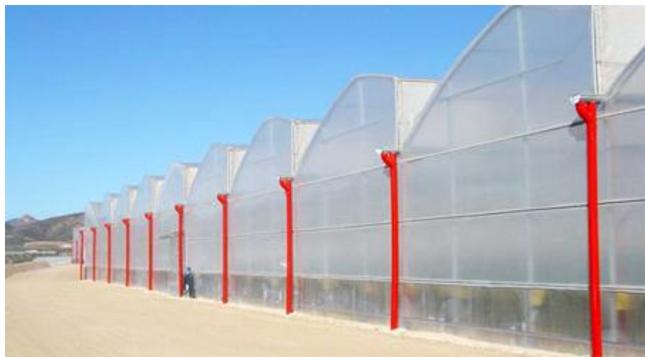
FIG. 5. Invernadero en dientes de sierra. Imag... hidroenv 2016)
