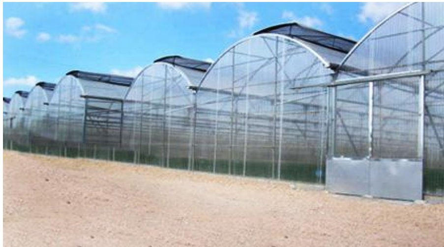
FIG. 7 Invernadero Con Techumbre Curva. (Hidroenv, 2016)
