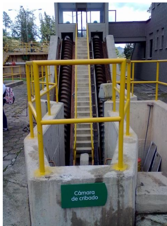
Figura 7. Bombeo del agua cruda bombas de Arquímedes.
