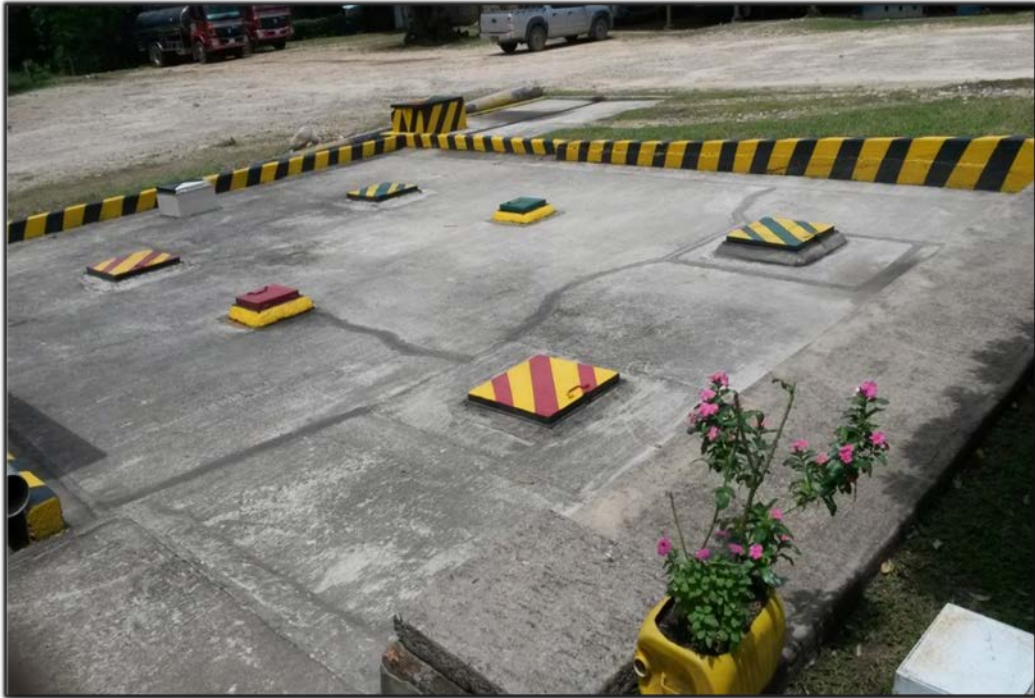
Imagen 8. Zona de almacenamiento y descargue de combustible.
