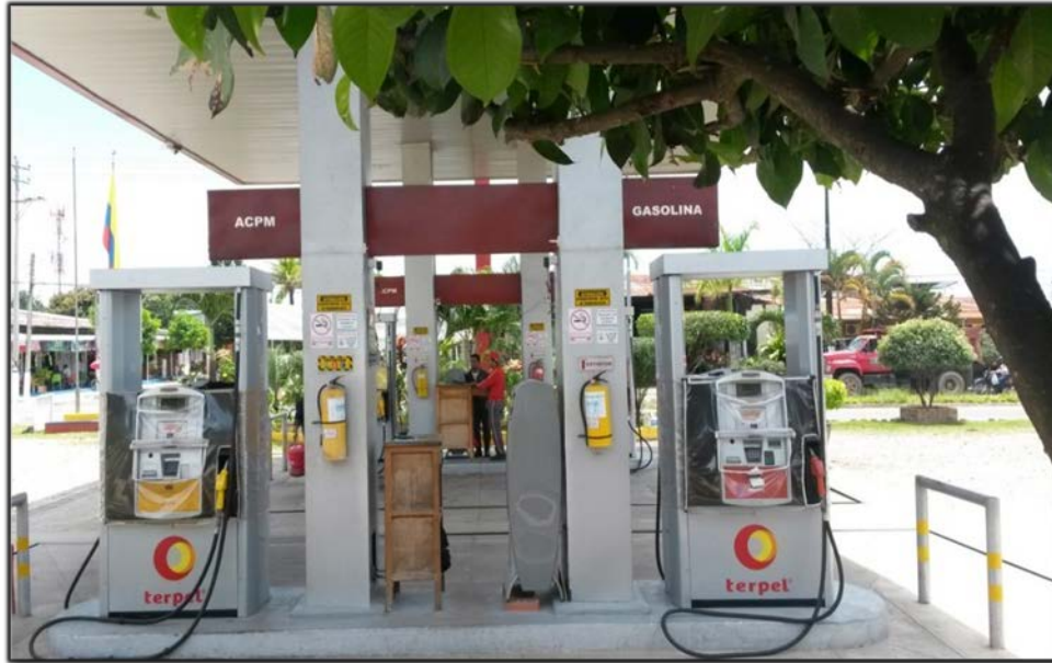
Imagen 3. Surtidores para suministro de combustible. 2
