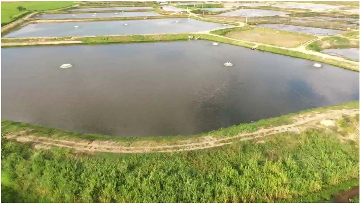
Figura 35. Operación de drone Piscícola Los Rosales
