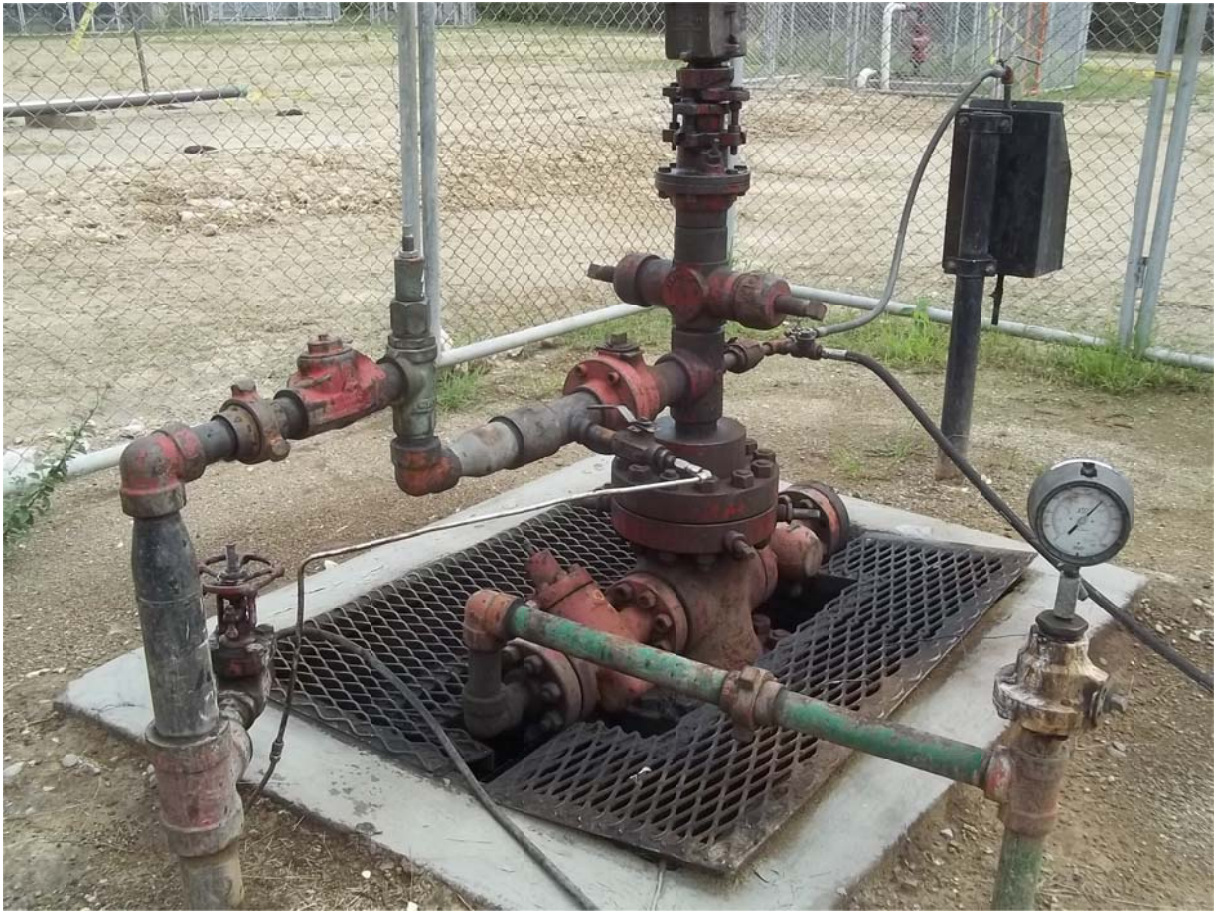
Figura 10. Árbol de navidad cabezal de pozo. Fuente: Hocol.
