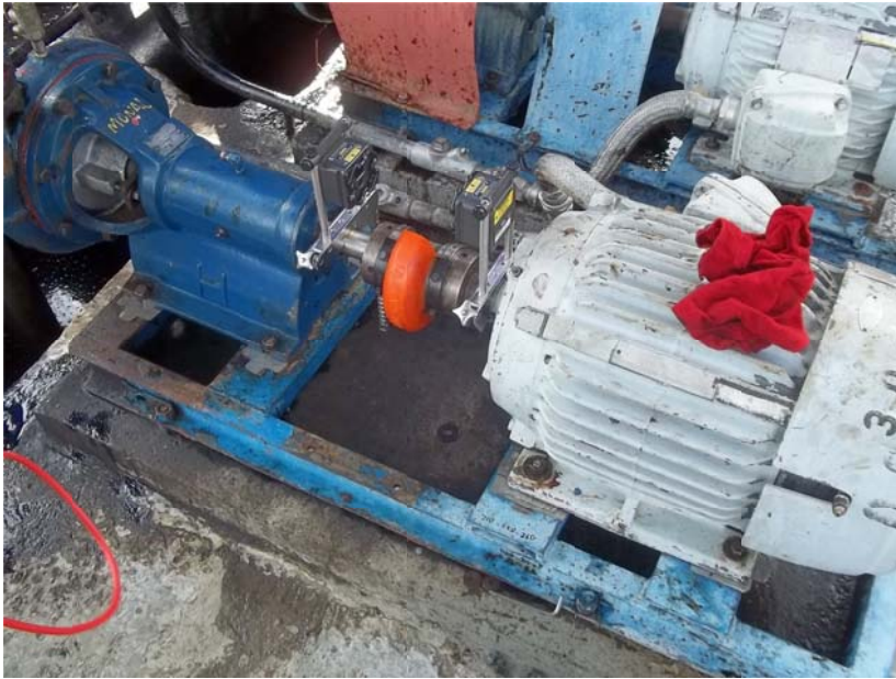
Figura 17. Alineación ejes motor/bomba. Fuente Hocol.
