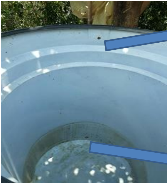
Fig.15. Perforación entrada y salida tubería Fuente: El autor
