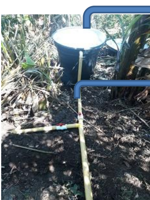
Fig. 20. tubería instalada por gravedad a filtro Fuente: El Autor
