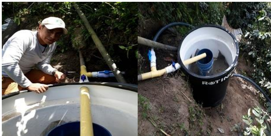
Fig. 25.26. Entrega del dispositivo instalado al productor Fuente: El Autor
