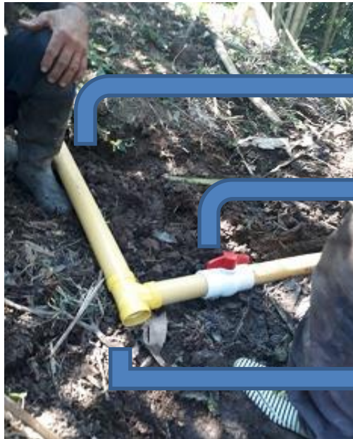
Fig. 18. conducción de tanques a filtro Fuente: El Autor
