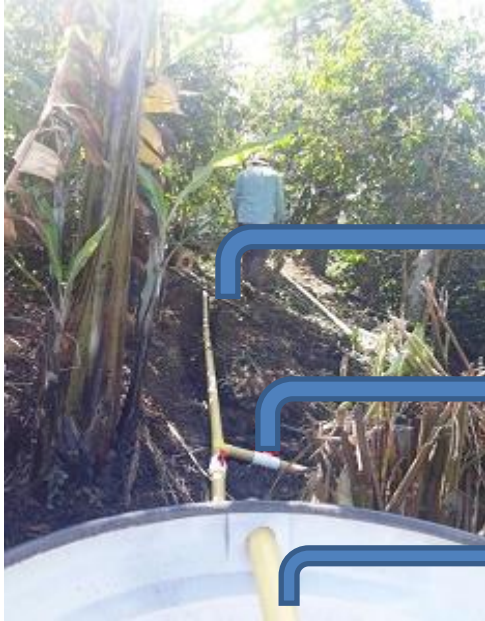
Fig. 19. tubería instalada por gravedad a filtro Fuente: El Autor
