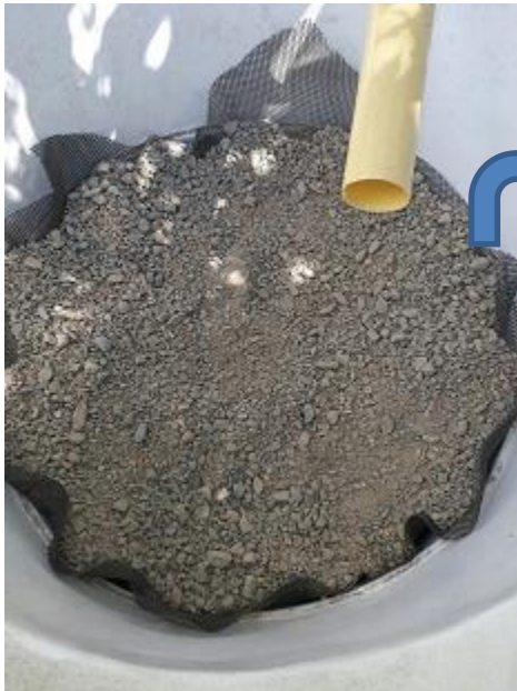
Fig. 23. llenado de gravilla segunda Fuente: el Autor
