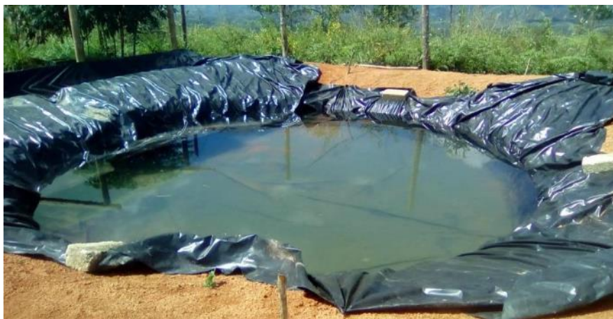
Imagen 55: reservorio de agua lluvia
