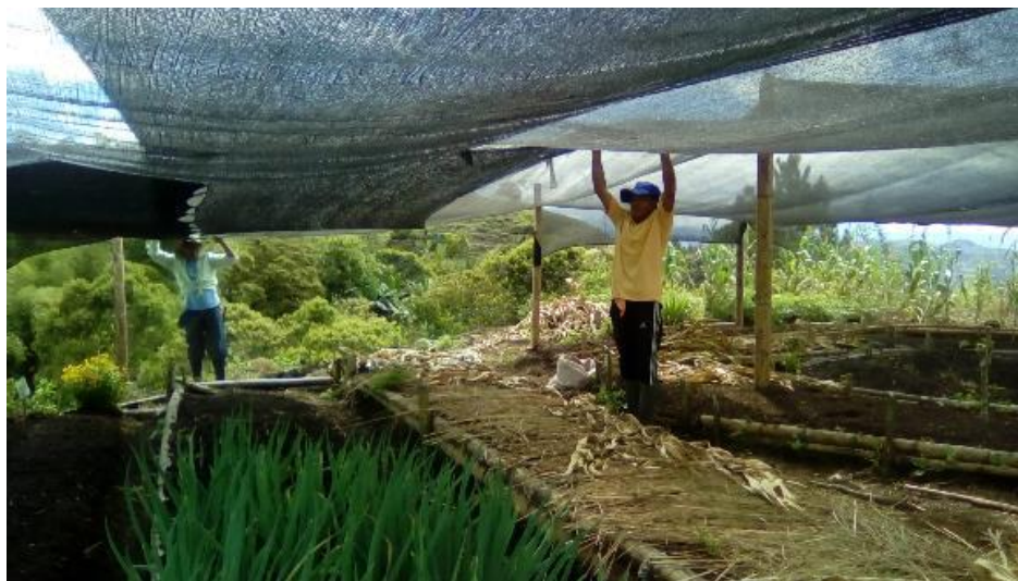
Imagen 39: instalación de poli sombra
