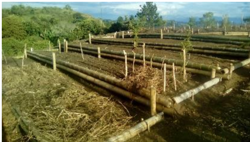
Imagen 37: construcción de eras longitudinales
