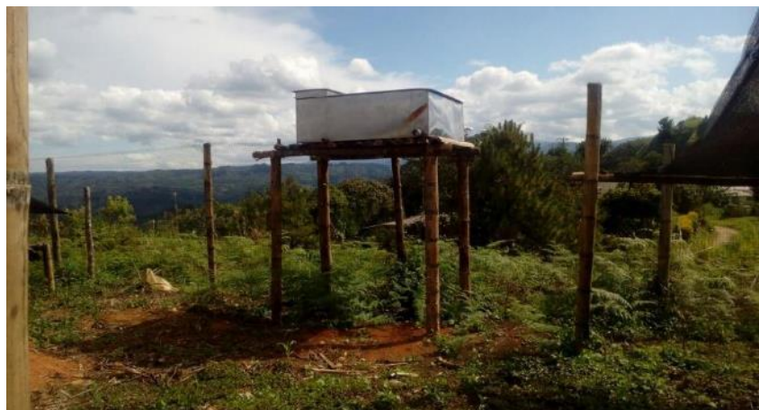
Imagen 59: instalación del tanque para almacenamiento de agua
