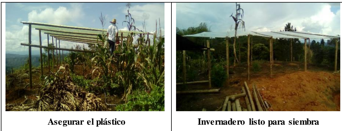
Imagen 53: construcción de invernadero
