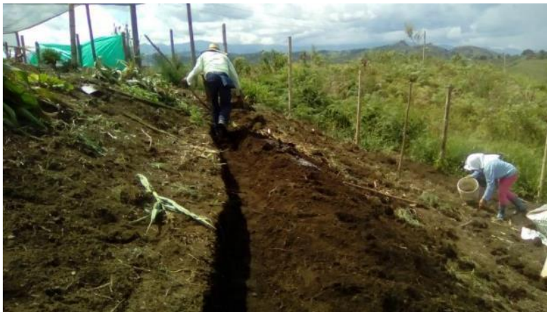
Imagen 49: elaboración de zanjas de infiltración
