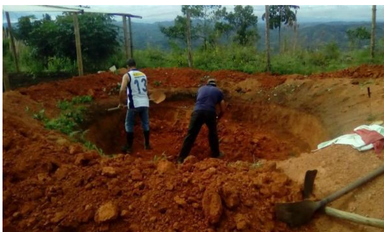
Imagen 54: Excavando el reservorio de agua
