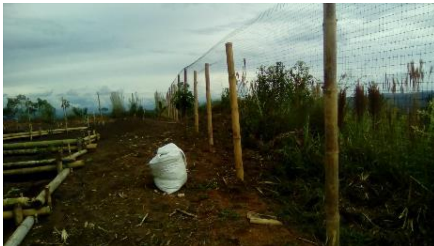
Imagen 36 instalación de malla
