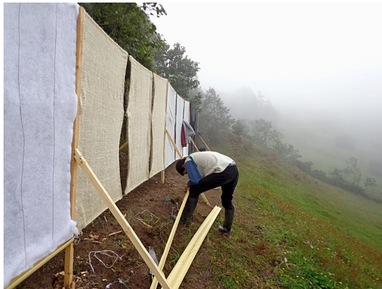
Figura 19. Instalación de canaleta colectora
