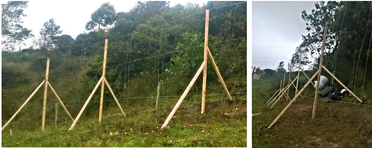
Figura 13. Construcción de la estructura
