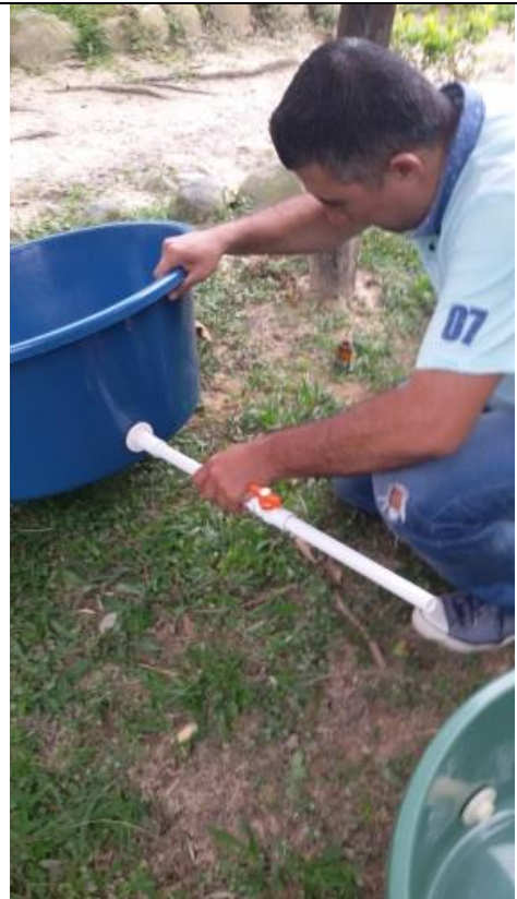
Ilustración 5. Montaje tubería de conexión- piscinas
