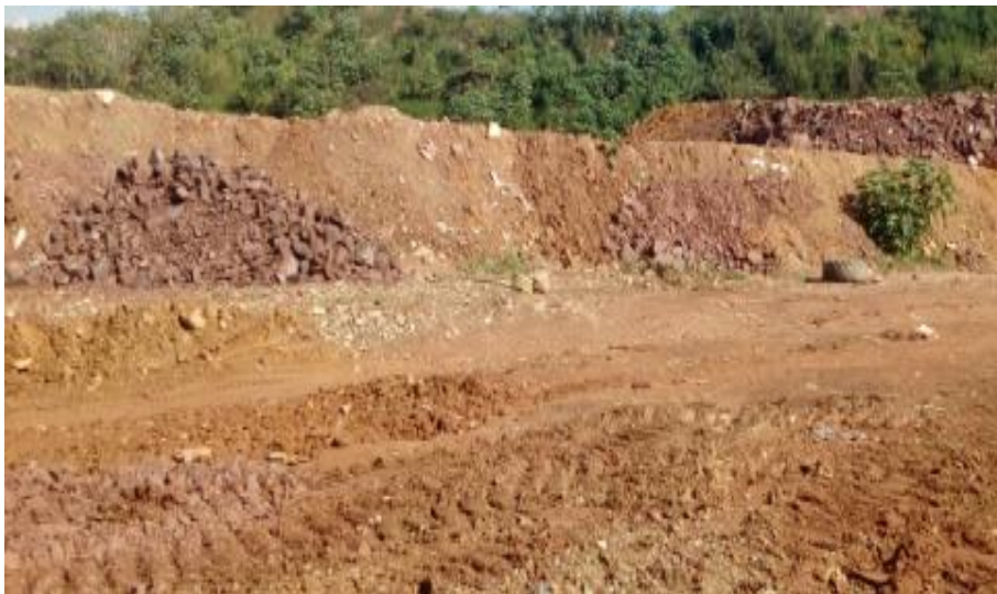
Imagen 16. Perfilado y adecuación de talud para iniciar proceso de revegetalización
