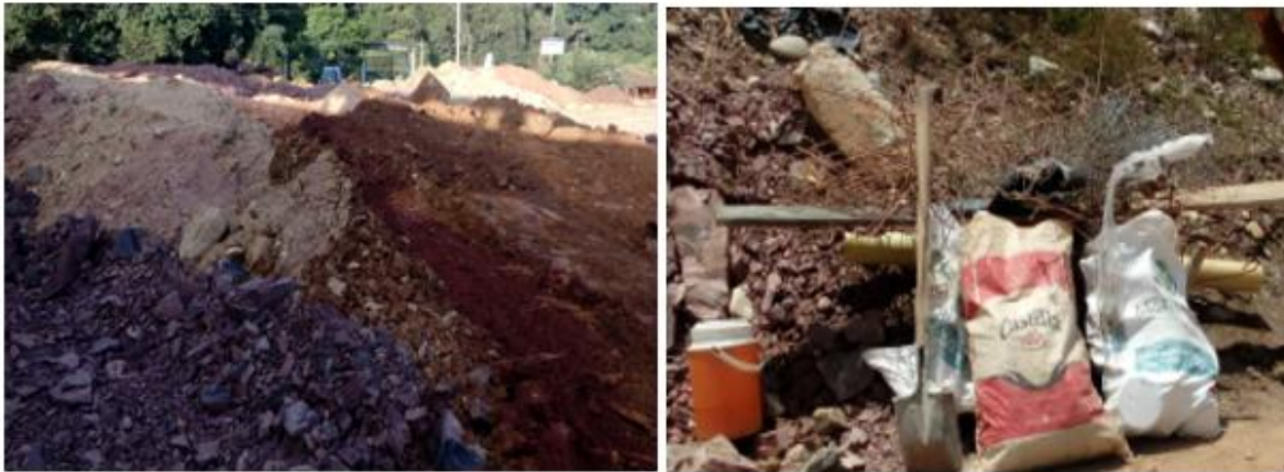
Imagen 17. Separación de material para adecuación de talud y retiro de residuos pétreos y no pétreos.
