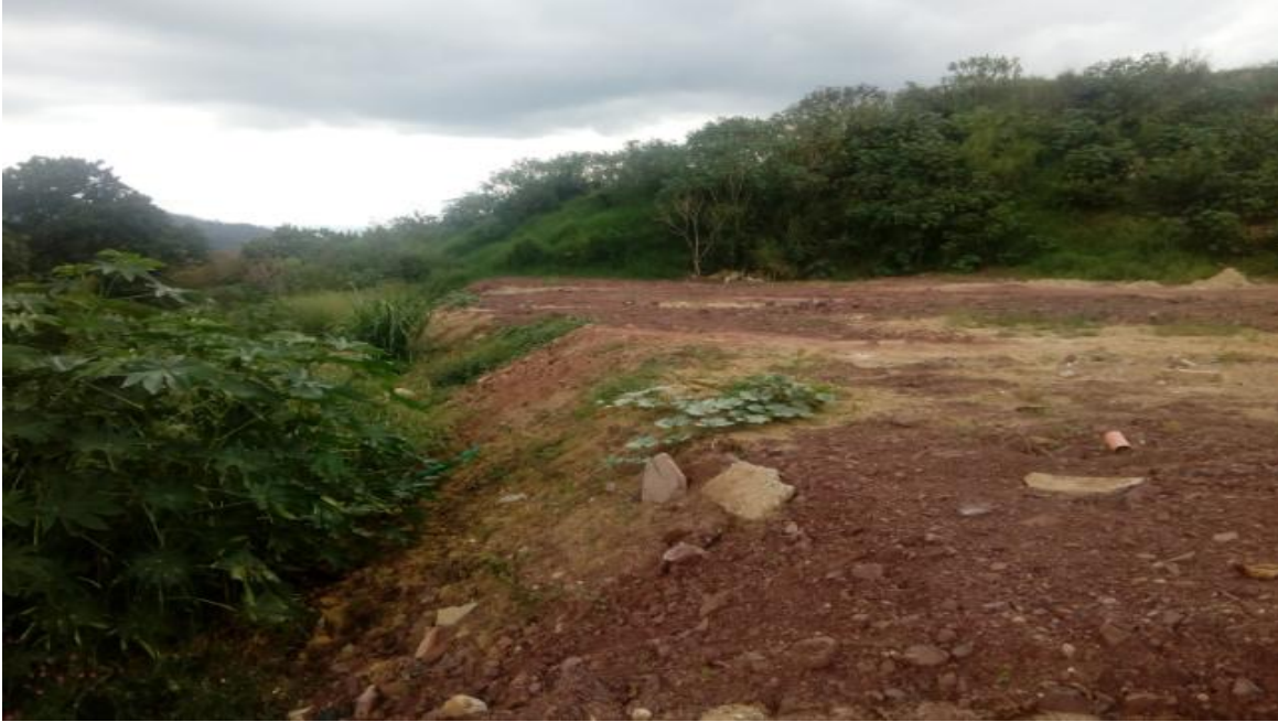
Imagen 21. Panorámica de talud celda 1 y celda 2
