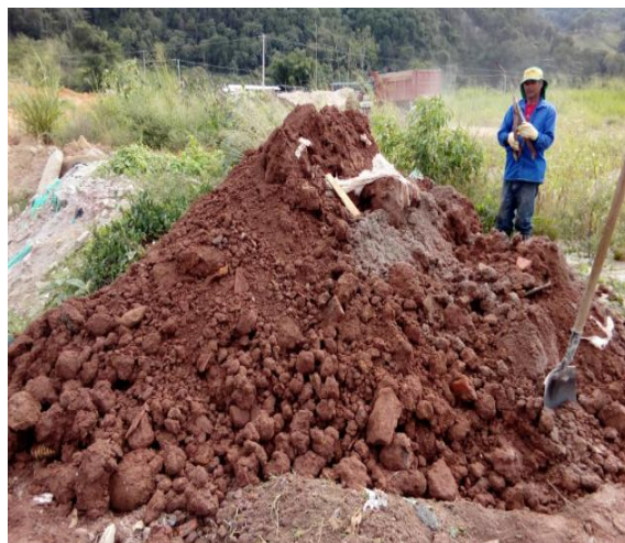
Imagen 5. Material de corte de talud
