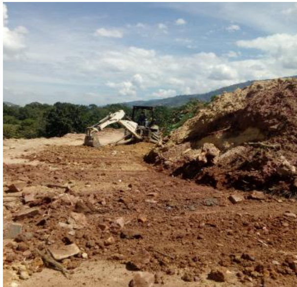
Imagen 4. Perfilado y adecuación de talud
