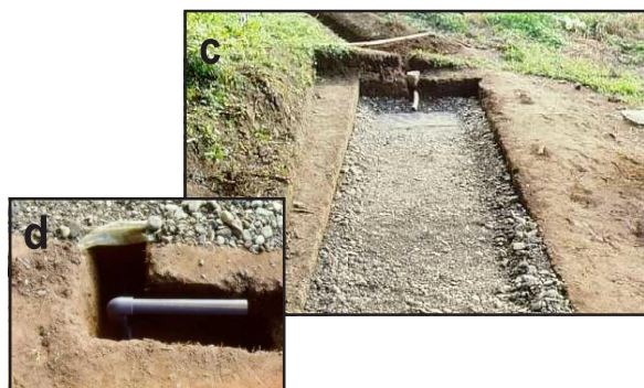
Figura 14, Filtro opcional de pos-tratamiento: a) excavación de tierra, b) impermeabilización del fondo con plástico Agrolene calibre 5, c) llenado final del lecho, d) salida para controlar el nivel del agua dentro del lecho, e) Thypha Angustifolia sembrada en el lecho del filtro, (Zambrano, Isaza, Rodrigues, Lopez, p.22).
