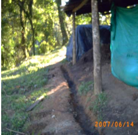
Cuneta de desagüe del umbráculo
