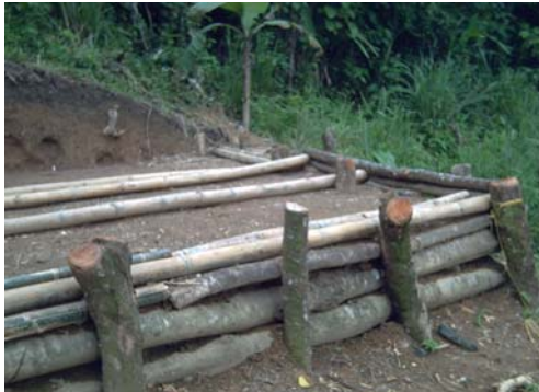
Construcción de los germinadores
