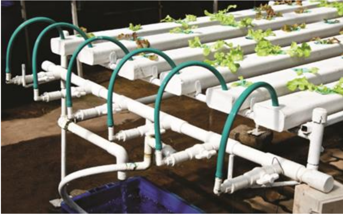
Figura 25. Red de distribución y tubería colectora del sistema NFT.
