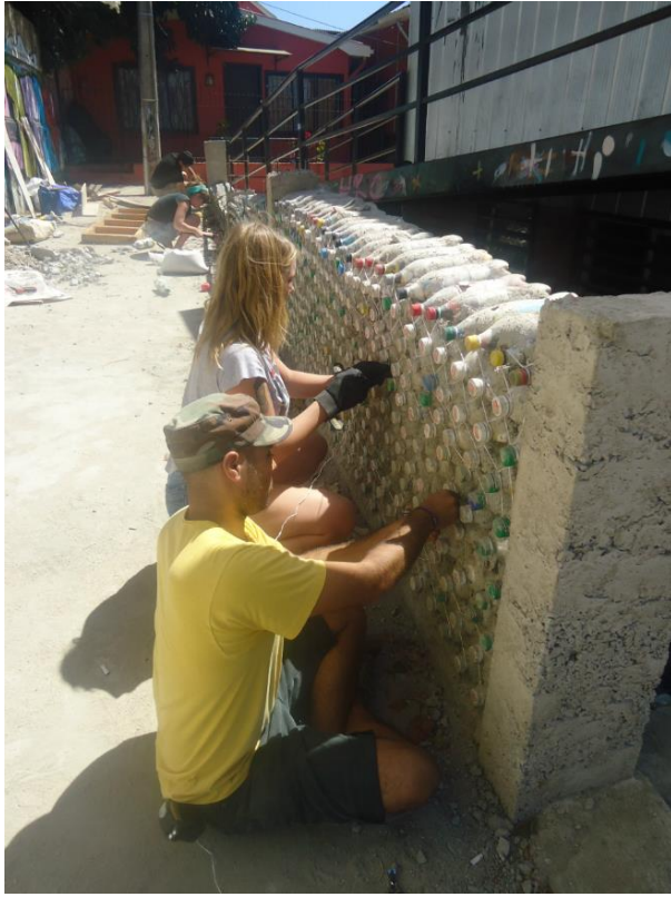
Ilustración 7 Construcciones con Ecoladrillos
