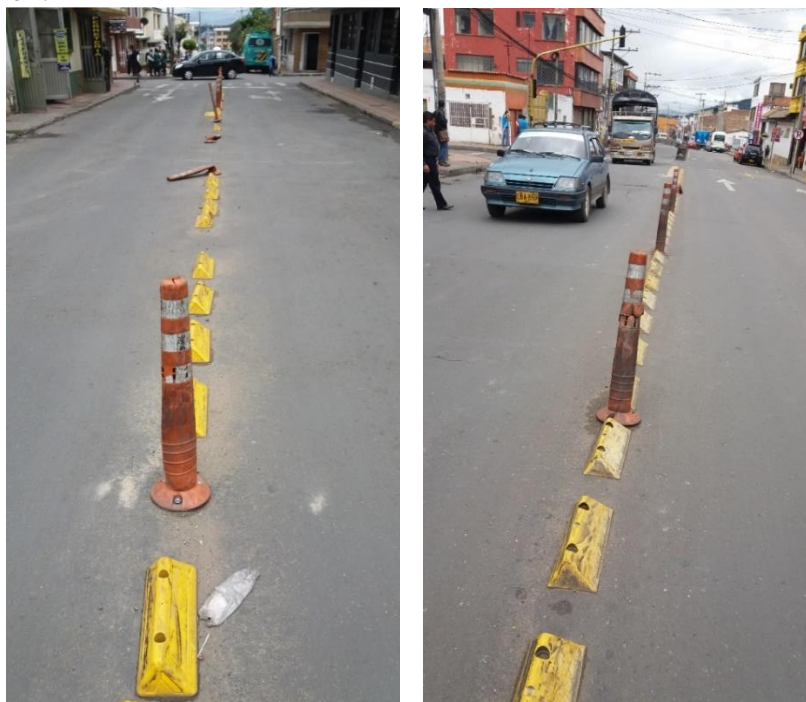
Figura 18 Señalización, Zipaquirá calle 8 y 10 con carrera 10
