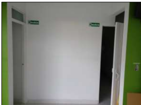
Figura 2. Área de baños.
