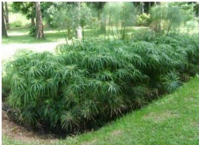
Ilustración 5. Humedal construido de flujo subsuperficial horizontal en la empresa farmacéutica. Fuente: (Salazar et al., 2013)
