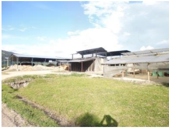
Fotografía 2. Entrada a la Ladrillería Villa Laura
