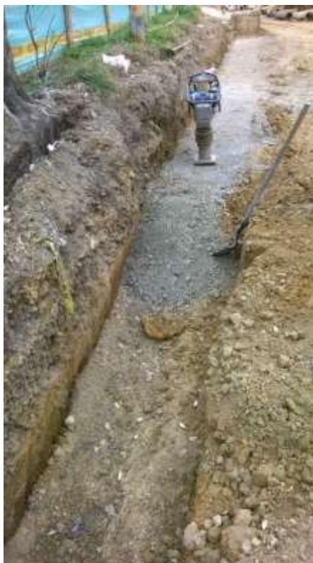
FIGURA 22: Aprovechamiento del material extraído en sitio en obras de alcantarillado.
