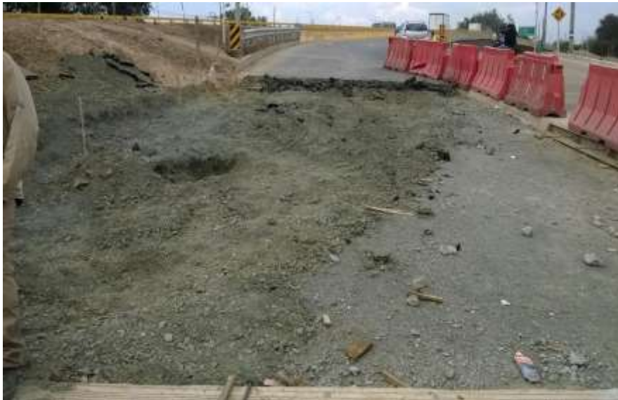
FIGURA 19: Demolición de vías existentes, material sub-base granular de sitio
