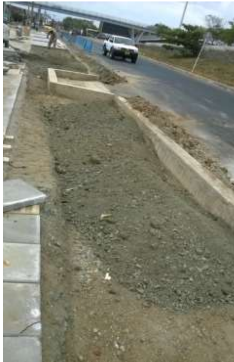
FIGURA 20: Aprovechamiento del material sub-base de sitio en estructuras menores - andenes.
