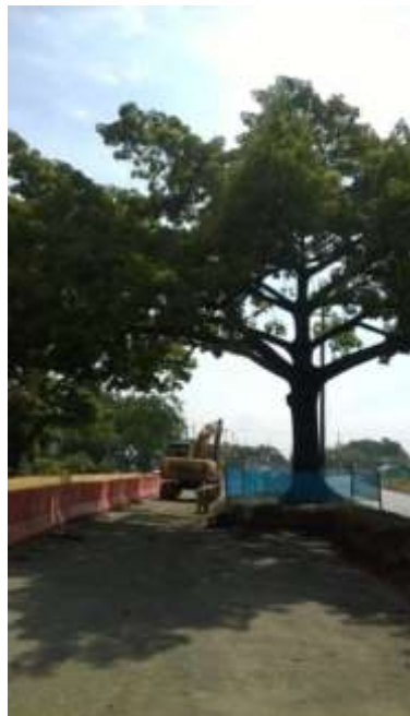
FIGURA 10: Ceiba afectada por intervención vial.
