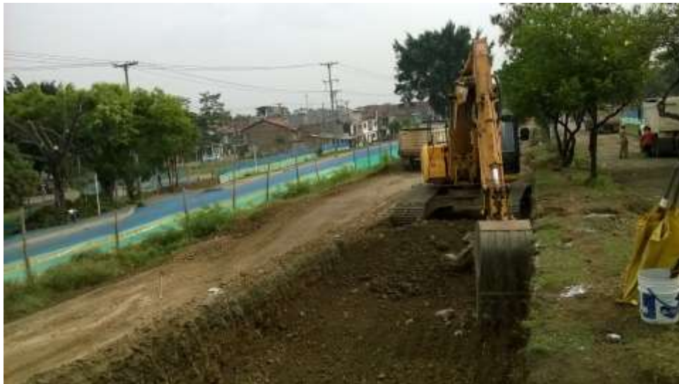
FIGURA 21: Material roca muerta extraída durante el proceso de excavación de vías existentes.
