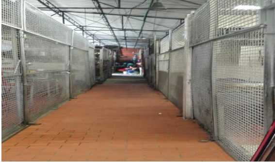
Figura 6. Locales sin actividad comercial.
