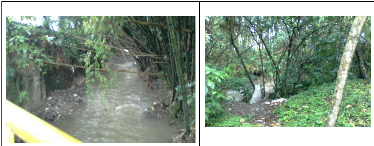
Obras de estabilización de laderas, depósito de residuos sólidos
