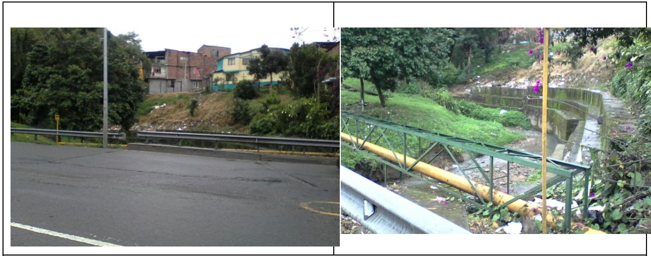
Obras de estabilización de laderas y depósito de residuos sólidos
