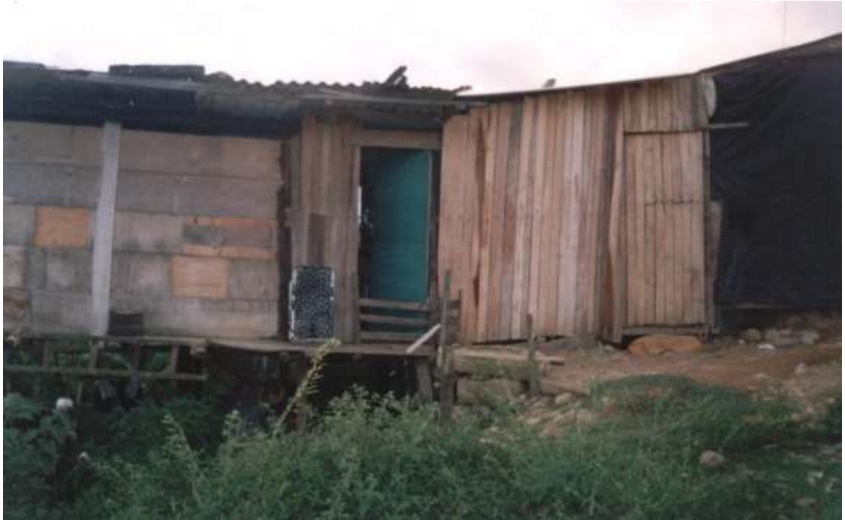
Fachada casa de desplazado ubicada en el sector de Nueva Colombia, Florencia Caquetá.
