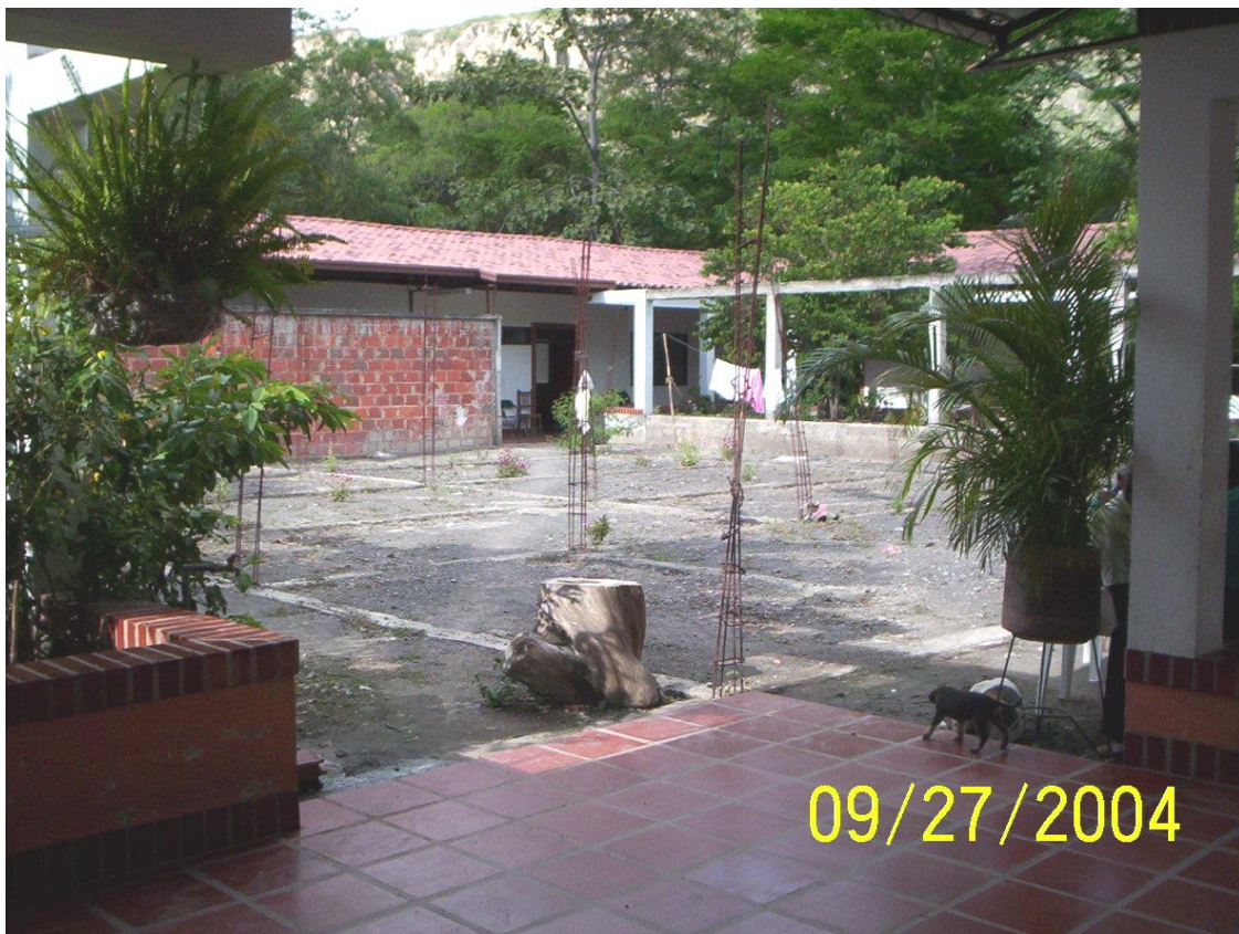
Figura 5. Pabellón para pensionado Fundación Hogar San Francisco de Asís
