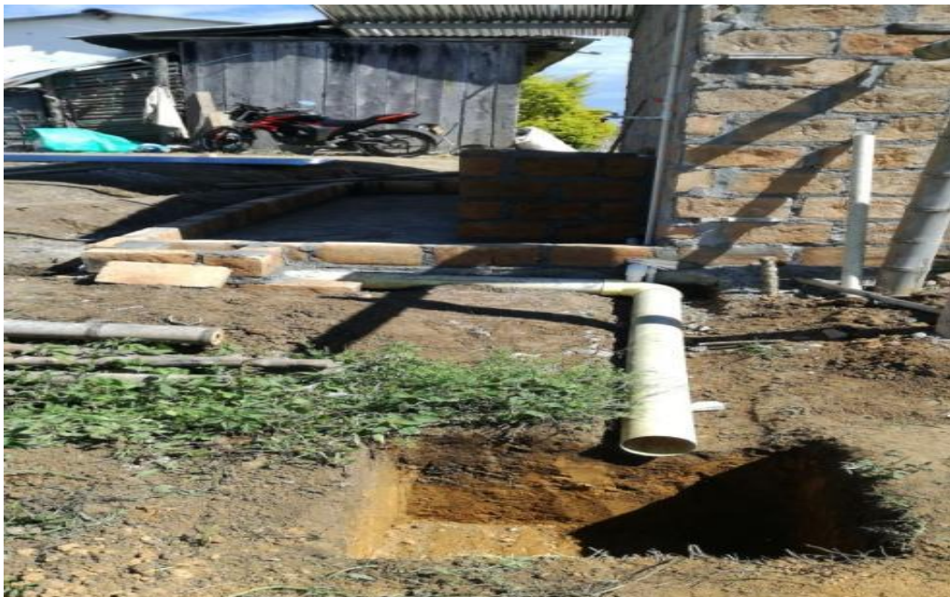
Ilustración 25. Adecuación de sistema de drenaje de aguas.
