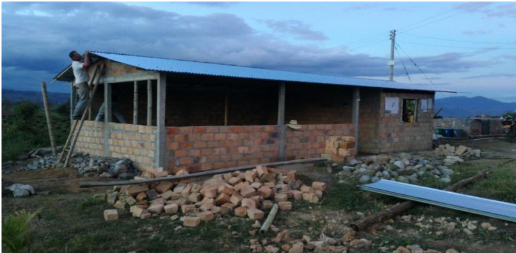
Ilustración 15. Construcción bodega en unidad productiva la Floresta.
