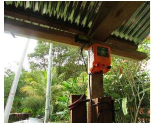
Figura 10. Controlador e impulsor Fuente:: Ricardo Urbano
