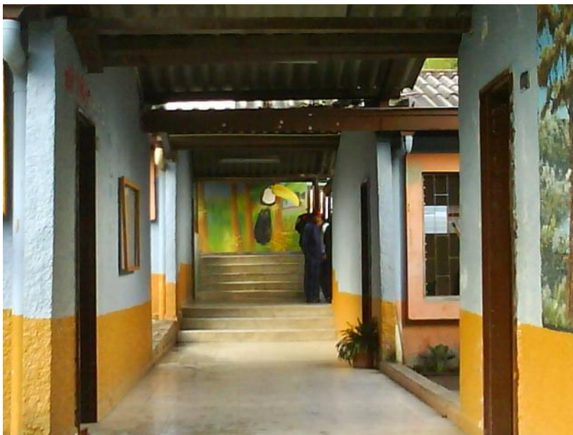
Foto de la planta física de la IE Luis Eduardo Posada Restrepo
