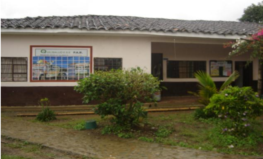
Figura 12 Vista del Colegio Jose Maria Cordoba
