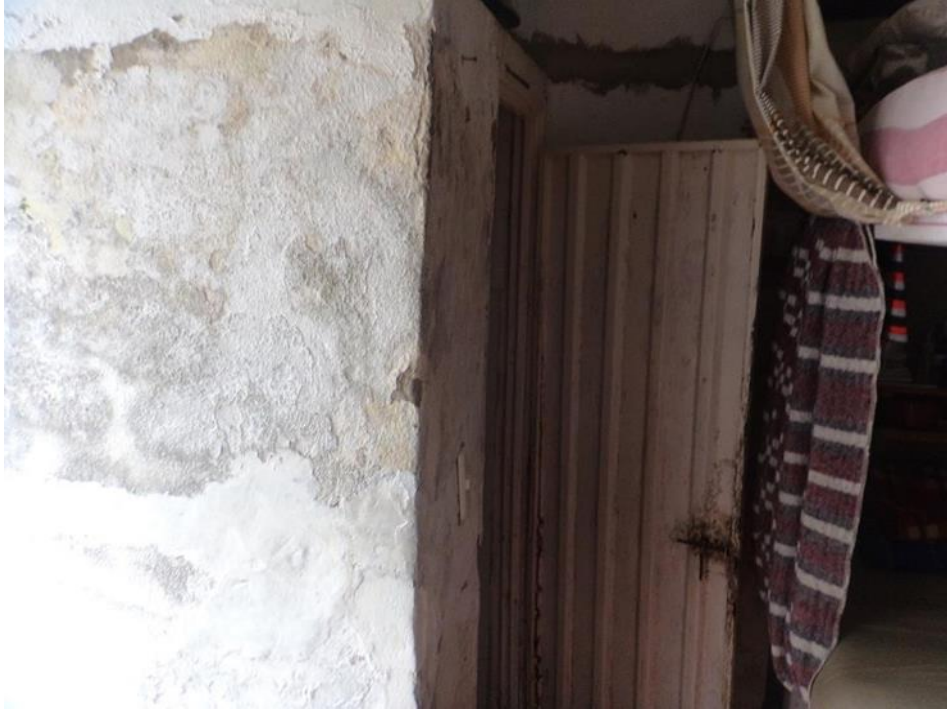
Figura 14. Vista lateral baño alojamiento.
