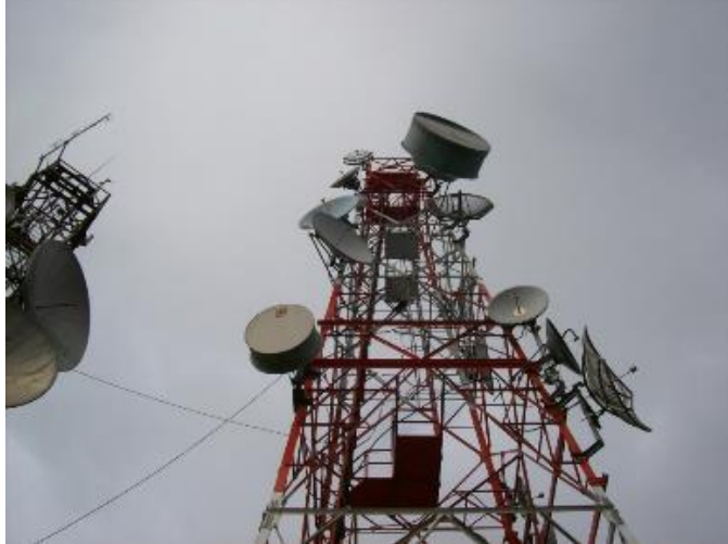
Figura 26. Torre de instalación con montaje de antenas. Fuente: autoría propia, 2018
