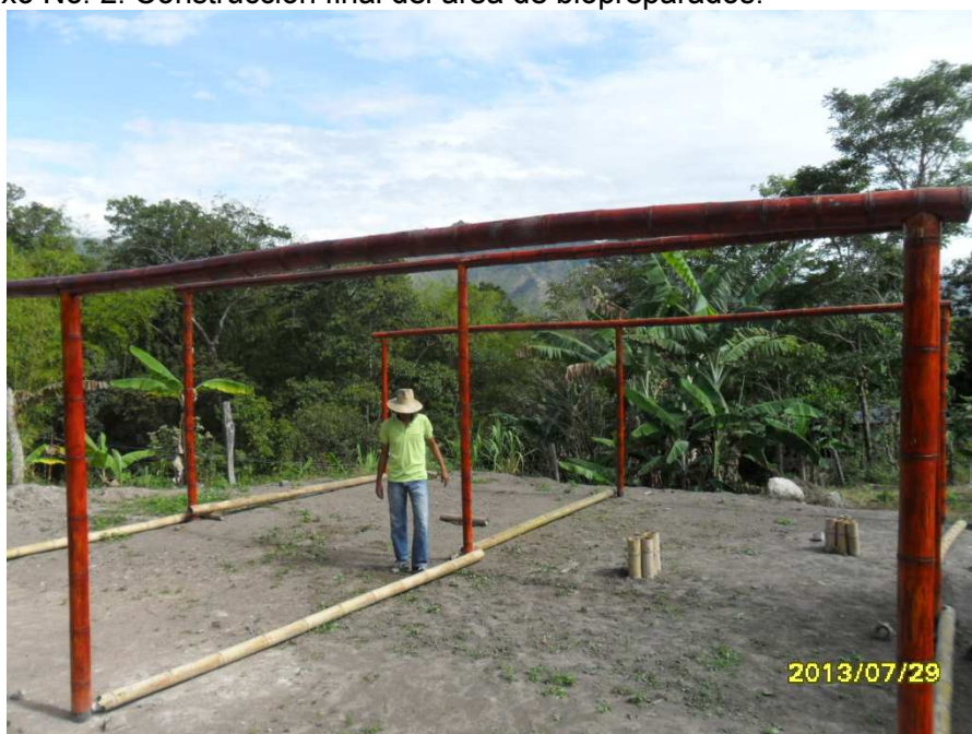
Anexo No. 2. Construcción final del área de biopreparados.
