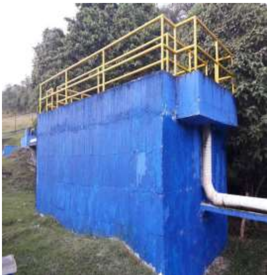
FIGURA 30. TUBERÍA ELEVADA Fuente: CAM Territorial Sur
