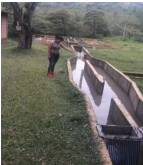
FIGURA 34. REJILLA DE LA ZONA DE CRIBADO
