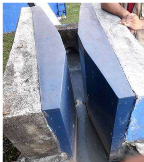
FIGURA 29. CANALETA PARSHALL Fuente: CAM Territorial Sur
