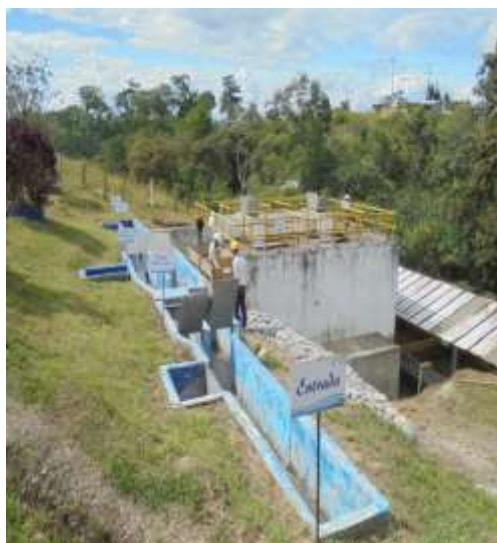
FIGURA 24. VISTA GENERAL DE LA PLANTA Fuente: CAM Territorial Sur
