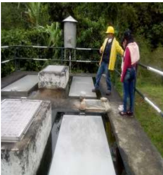
FIGURA 38. QUEMADOR DE GAS Fuente: Propia
