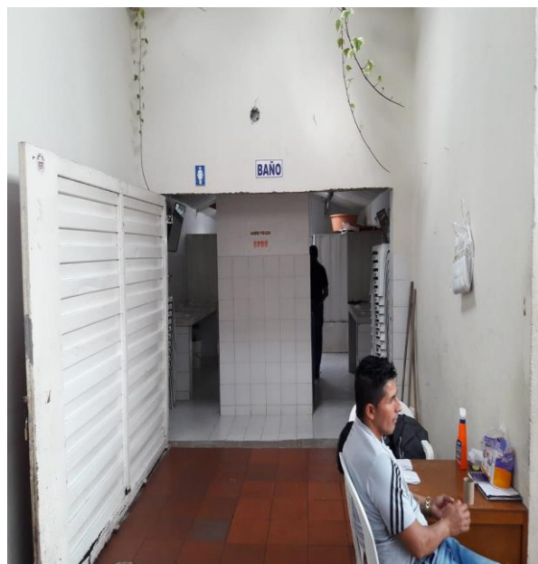
Figura 8. Unidades Sanitarias de la Plaza de Mercado Fuente: Propia
