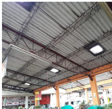
Figura 30. Cubiertas y Estructuras Metálicas Fuente: Propia
