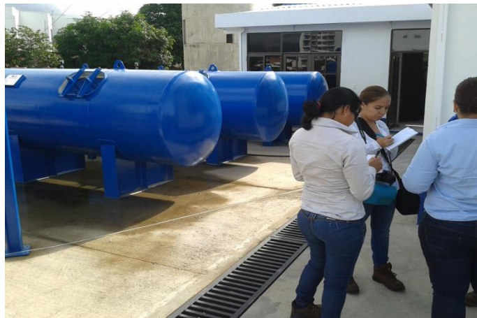
Figura 25. Pozo profundo villa maría II
