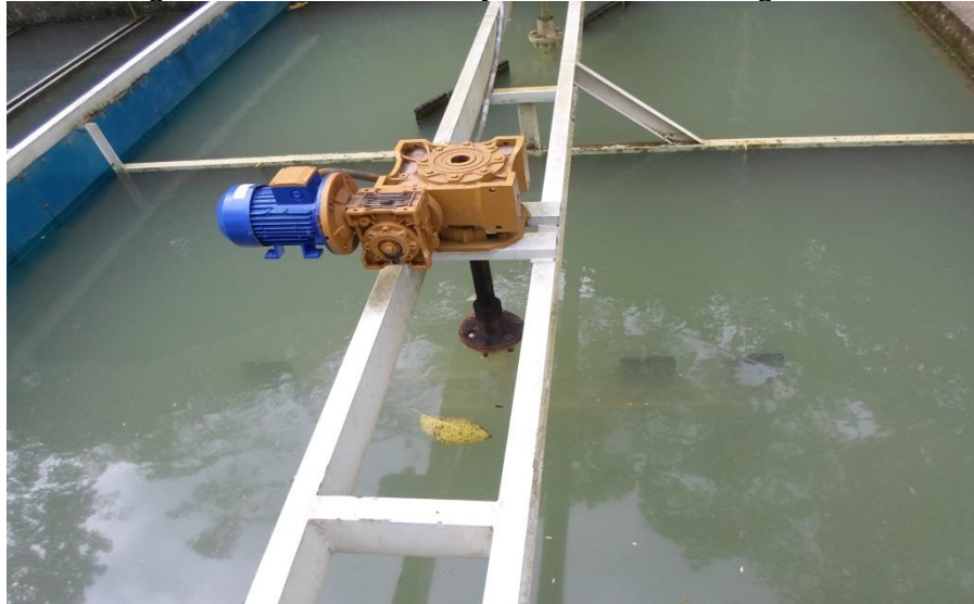
Figura 18. Moto-reductor y mezclador de coagulante.
