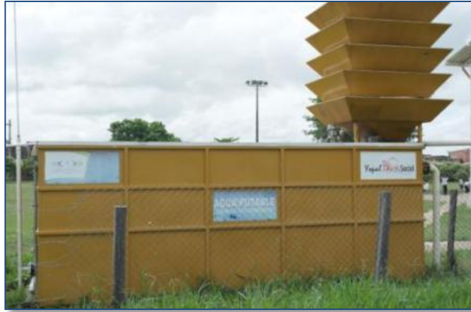
Figura 26: Planta de Tratamiento San Jorge
