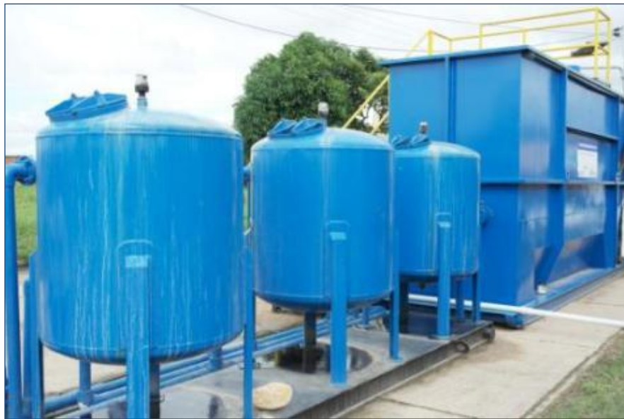
Figura 27: Pozo profundo Estadio
