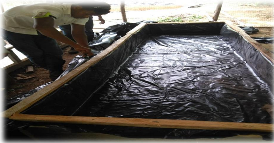
Figura 20. Recubrimiento con plástico en zona interna
