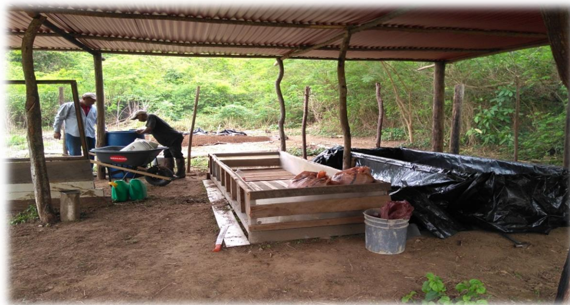
Figura 8.Cercado, techado y construcción de dos camas
