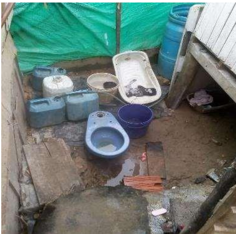
Fotografía 26 falta de saneamiento básico en las viviendas Fuente: Autor La falta de servicios públicos; acueducto y alcantarillado generan riesgos en salud pública y generan una barrera de acceso hacia la posibilidad de un desarrollo sostenible en las comunidades.
