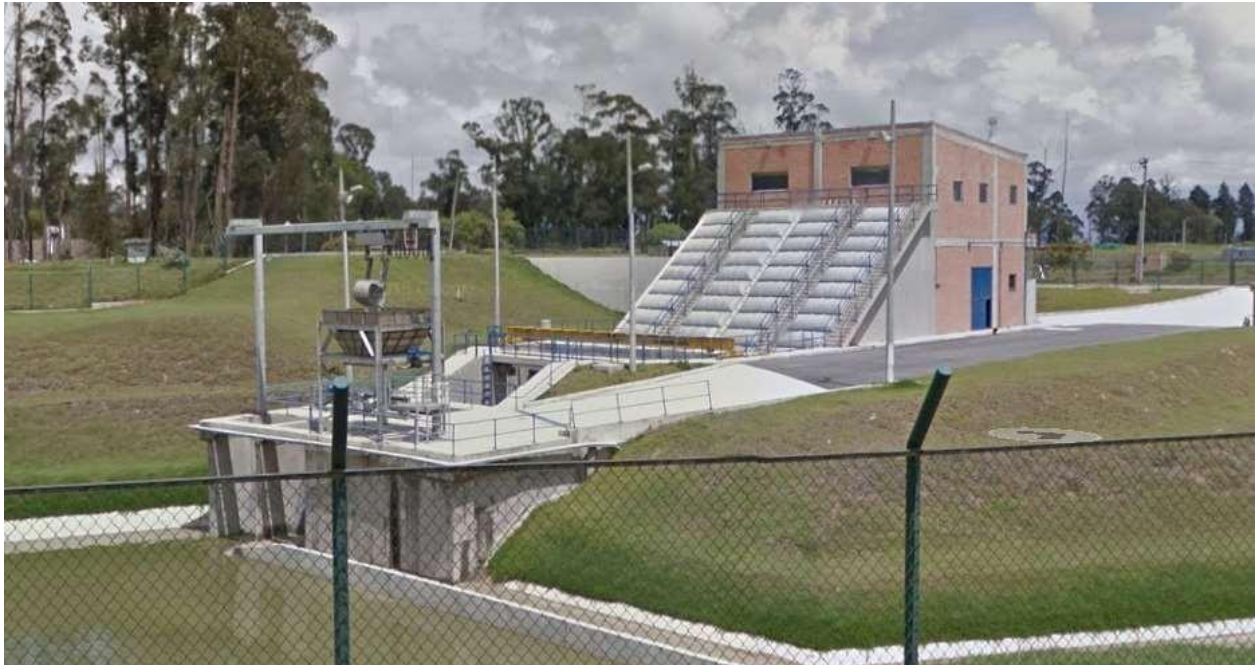
Fotografía Estación de bombeo ciudad verde fuente: autor
