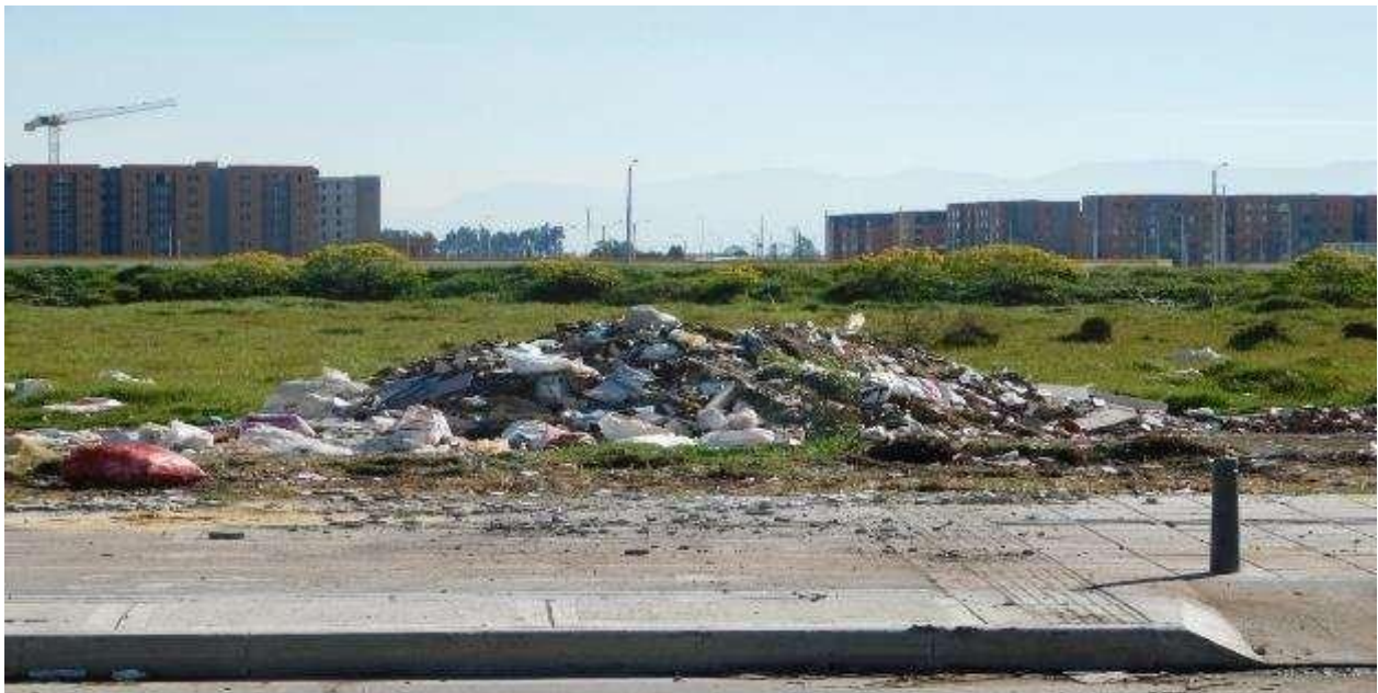
fotografía 24 punto crítico de acumulación residuos sólidos urbanos y RCD Fuente: Autor las actividades de expansión urbana generan puntos críticos de acumulación de residuos de construcción y demolición RCD generando focos de vectores riesgos para salud publica
