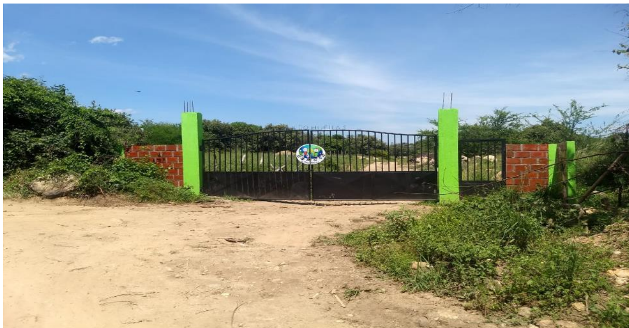
Figura 7. Entrada Granjas Comunitarias
